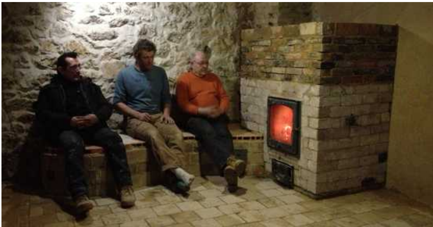
Poêle de masse fraîchement monté (avant pose d'enduit)
